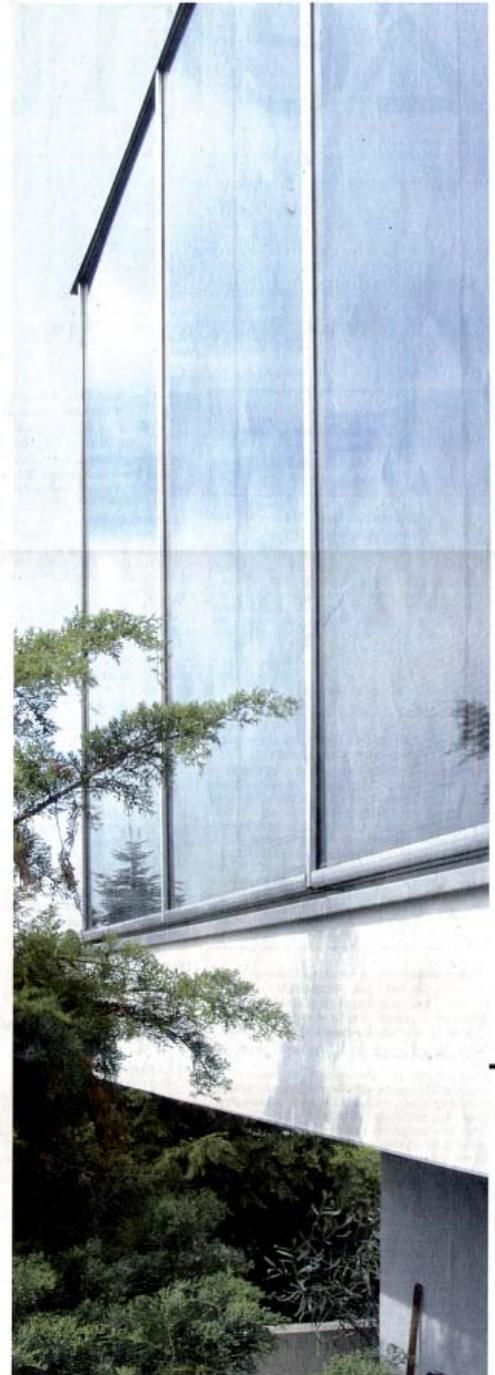
Vom Altbau zu Glasquader: Sonnenkollektoren bilden die Oberfläche des Gebäudes in Karlsruhe-Durlach. Foto: Presse-Team Stuttgart
