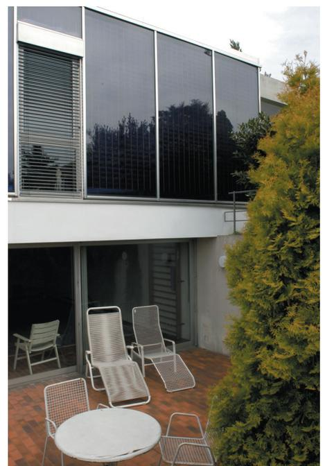
Die vorhandenen Fenster und Türen sowie den Edelstahlkamin hat Reyelts vollständig in die Fassade integriert. Zusammen mit den Verwahrungen und der neuen Attikaabdeckung aus einem zweiteiligen Aluminium-Winkelprofil wirkt alles wie aus einem Guss – als sei das Haus von Anfang an so geplant.
