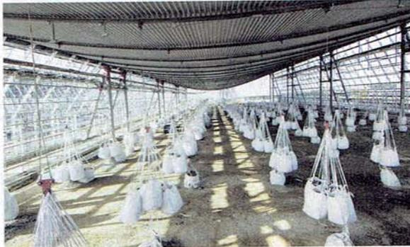
Um das fragile Dach bei Windböen im Lot zu halten, wurde es bis zur Fassadenmontage mit einigen hundert Sandsäcken beschwert.
